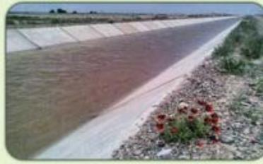
کanal های درجه ۲: کanalهای درجه ۲ منشعب شده از کanal EPC شبکه آبیاری سرخ از طرق ساخته امکانهای آبگیر که مجهز به دریچه های نیرپیک و سازه تنظیم سطح آب نوک اردکی بوده که آنها نیز مجهز به دریچه نیرپیک و سازه تنظیم سطح آب می باشند که آب را به قطعات زراعی هدایت می نمایند. جریان آب این کanalهای دائمی بوده و مقدار دهنی ، تابع نیاز آبی اراضی زیر پوشش آنها می باشد.
